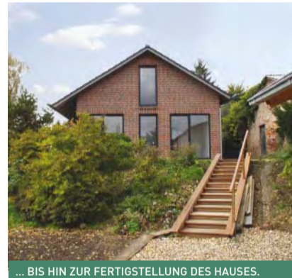
... BIS HIN ZUR FERTIGSTELLUNG DES HAUSES.
