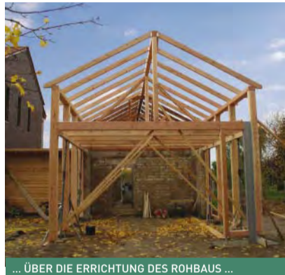
... ÜBER DIE ERRICHTUNG DES ROHBAUS ...
