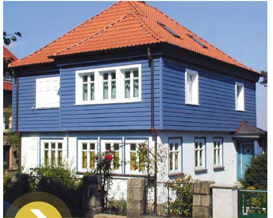
Altes schönes Haus mit Fassadendämmung im Neubauniveau. Fassadenprofil „Hoya-Holz Gränna“ mit dauerhafter Werksbeschichtung.
