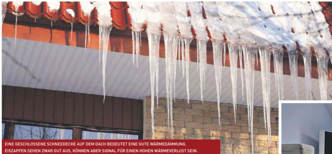
EINE GESCHLOSSENE SCHNEEDECKE AUF DEM DACH BEDEUTET EINE GUTE WÄRMEDÄMMUNG. EISZAPPEN SEHEN ZWAR GUT AUS, KÖNNEN ABER SIGNAL FÜR EINEN HOHEN WÄRMEVERLUST SEIN.
