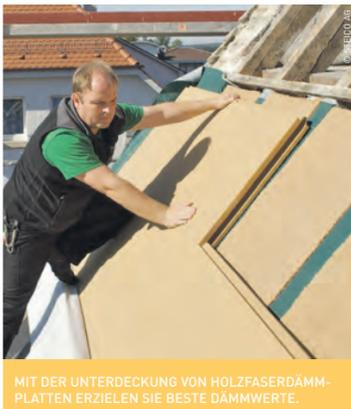
MIT DER UNTERDECKUNG VON HOLZFASERDÄMMLATTEN ERZIELEN SIE BESTE DÄMMWERTE.
