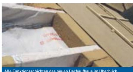
Alle Funktionsschichten des neuen Dachaufbaus im Überblick.
