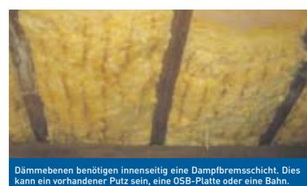
Dämmebenen benötigen innenseitig eine Dampfbremsschicht. Dies kann ein vorhandener Putz sein, eine OSB-Platte oder eine Bahn.
