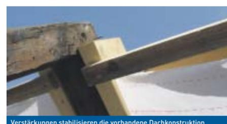
Verstärkungen stabilisieren die vorhandene Dachkonstruktion.
