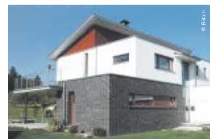
Eine Mischfassade – Verblendmauerwerk mit dunklem Farbspiel in Kombination mit Putz- und Holzoberflächen.
