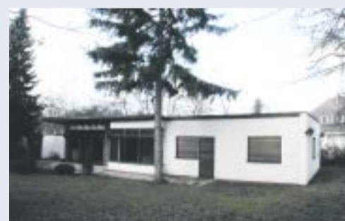
Vor dem Umbau ...
