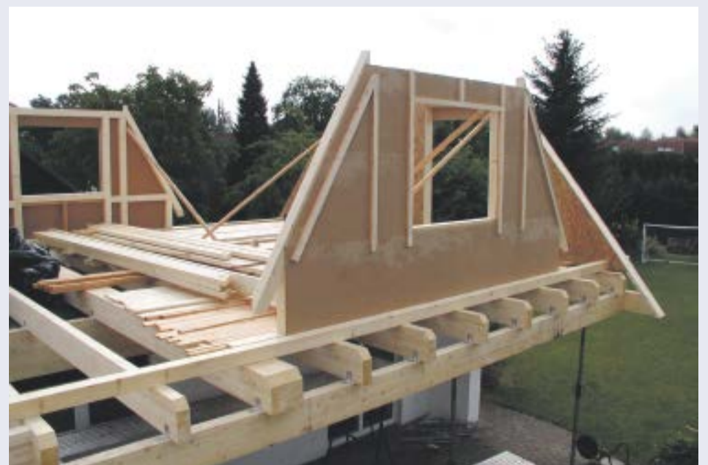
Mittels stabiler Holzbalkenlage wird die Basis für eine weitere Etage geschaffen.
