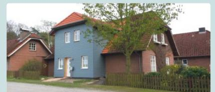
Ein nach außen verlagertes Treppenhäus ermöglicht neue Raumfolgen und Funktionen. Das Dachgeschoss wird nun separat erschlossen.
