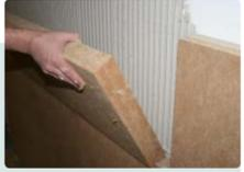
Bei erhaltenen Fassaden, insbesondere bei denkmalgeschützten Gebäuden, kann eine Dämmung von innen erfolgen. Je nach bestehender Außenwandkonstruktion ist eine Innendämmung in der Dicke zu begrenzen. Es muss verhindert werden, dass Feuchte dauerhaft im Bauteil verbleibt und sich ggf. von Jahr zu Jahr aufschaukeln kann. Zum Einsatz kommt eine sorptionsfähige (also feuchte-regulierende) Dämmung im Vollkontakt mit dem bestehenden Innenputz. Verschiedene Materialien sind möglich.
