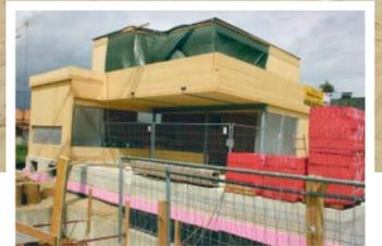
Insbesondere für vor- und rück-springende Geschosse sind die flächigen Elemente ideal geeignet. Dabei erfüllen die Bauteile alle Anforderungen an Statik und Aussteifung, Brandschutz und Bauphysik.
