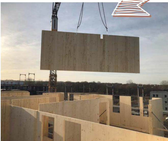
Aus einem Stapel Rundholz werden Bretter gesägt. Durch kreuzweise Verklebung einzelner Brettlagen entsteht aus den kleinformatischen Holzquerschnitten ein einfacher Werkstoff mit Platten- bzw. Scheibenwirkung. Brettsperrholz wird auch als KLH (Kreuzlagenholz)
