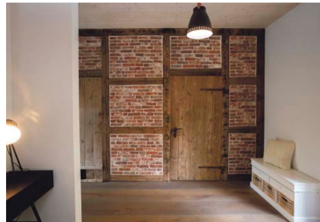
Spannende Verzahnung von Alt und Neu: Im Neubau bestehen zwei mit Altklinkern ausgemauerte Fachwerkwände aus den historischen Baumaterialien der alten Scheune.
